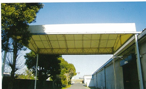
施工例：工場荷捌き場
