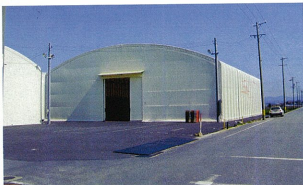
施工例：テント倉庫
